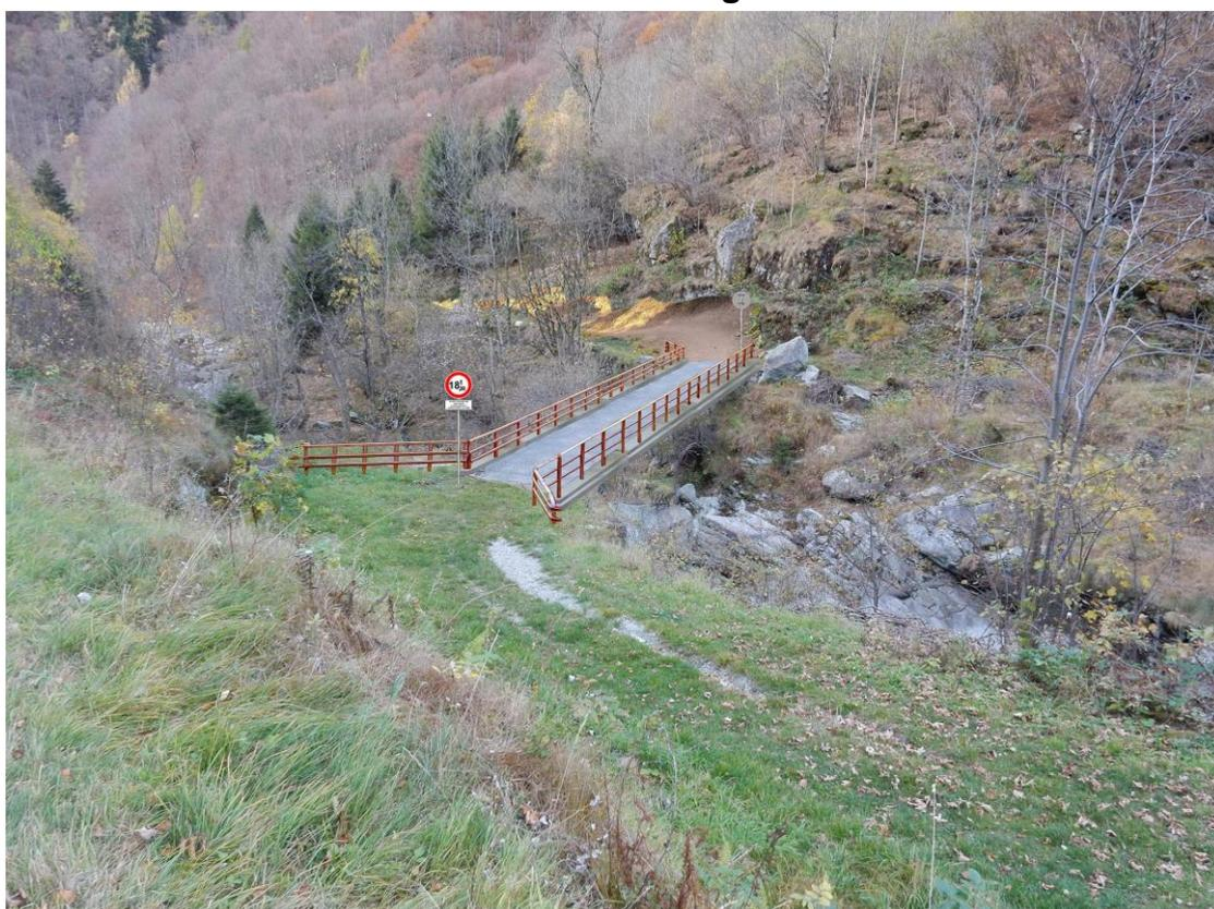
Pilastro centrale che non verrà più ricostruito (nuovo ponte ad una sola campata) larghezza ampliata di 1,4 metri (da 2,2 metri a 3,60 metri), soletta in calcestruzzo più snella, putrelle inferiori in corten non visibili da questo punto di osservazione, guardrail in lamiera zincata sostituito da ringhiera in acciaio corten di aspetto più leggero e snello oltre alla colorazione bruno-ferruginosa che meglio si inserisce nel contesto paesaggistico in esame.
