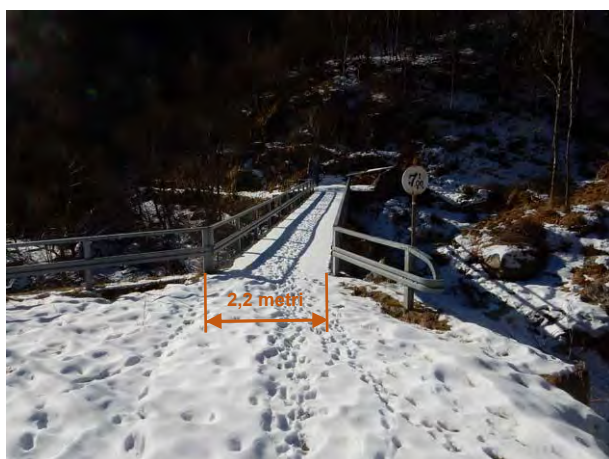
Fotografia 4 - Il ponte preesistente a servizio del sentiero di accesso alla destra idrografica della Val d'Egua (inizio Valle del Lampono) che sarà demolito e ricostruito con aumento della larghezza ma con adattamenti tecnico costruttivi meno impattanti.
