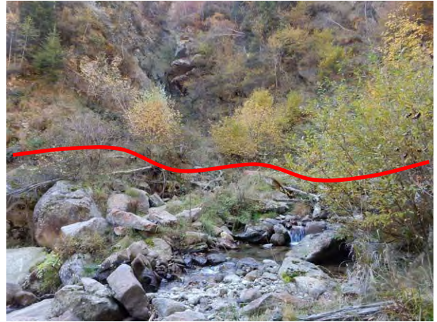
Fotografia 26 - Vista d'insieme dell'attraversamento sul Rio Penna, corso d'acqua demaniale per il quale si otterrà idonea autorizzazione idraulica all'attraversamento.
