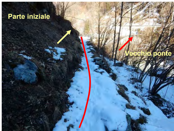
Fotografia 13 - Altre immagini del proseguimento della strada forestale, al fondo la parte iniziale ed il vecchio ponte da demolire e ricostruire con struttura visivamente più leggera e colorazioni più idonee ai luoghi; il primo tratto della strada forestale si sviluppa su una mulattiera esistente.
