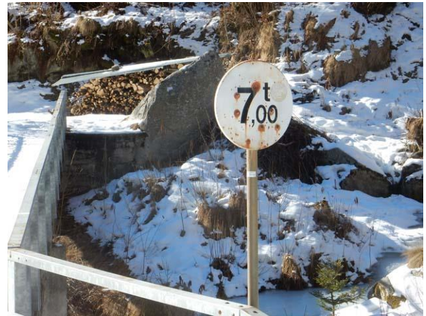
Fotografia 5 - Dettaglio del cartello indicatore della portata massima del ponte esistente, insufficiente alle necessità di una strada forestale.
