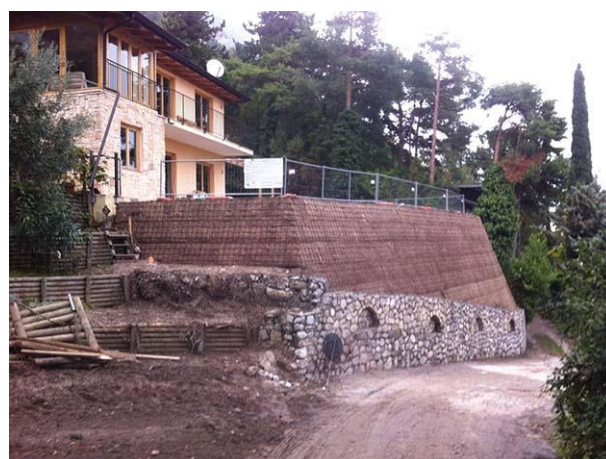
La terra armata come si presenta al termine della
