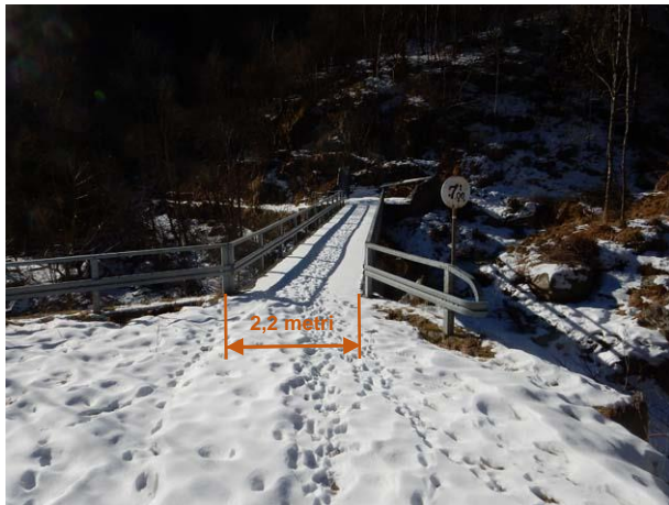
Fotografia 4 - Il ponte preesistente a servizio del sentiero di accesso alla destra idrografica della Val d'Egua (inizio Valle del Lampone) che sarà demolito e ricostruito con aumento della larghezza ma con adattamenti tecnico costruttivi meno impattanti.
