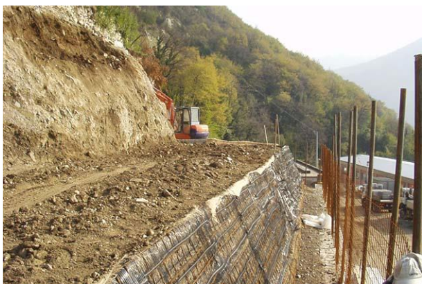
Costruzione della terra armata: in basso si vede il cassero metallico, in alto il piano di lavoro con compattamento del terreno tramite mezzo cingolato.
