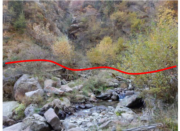
Fotografia 26 - Vista d'insieme dell'attraversamento sul Rio Penna, corso d'acqua demaniale per il quale si otterrà idonea autorizzazione idraulica all'attraversamento.
