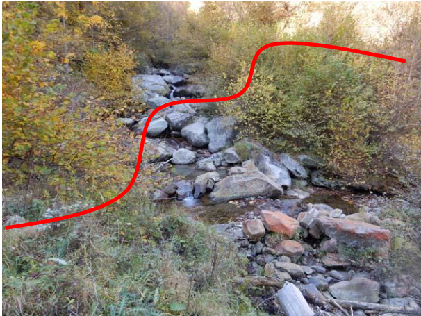
Fotografia 25 - Particolare dell'attraversamento sul Rio Penna che verrà realizzato con guado con andamento "a corda molle".
