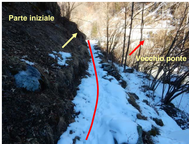
Fotografia 13 - Altre immagini del proseguimento della strada forestale, al fondo la parte iniziale ed il vecchio ponte da demolire e ricostruire con struttura visivamente più leggera e colorazioni più idonee ai luoghi; il primo tratto della strada forestale si sviluppa su una mulattiera esistente.
