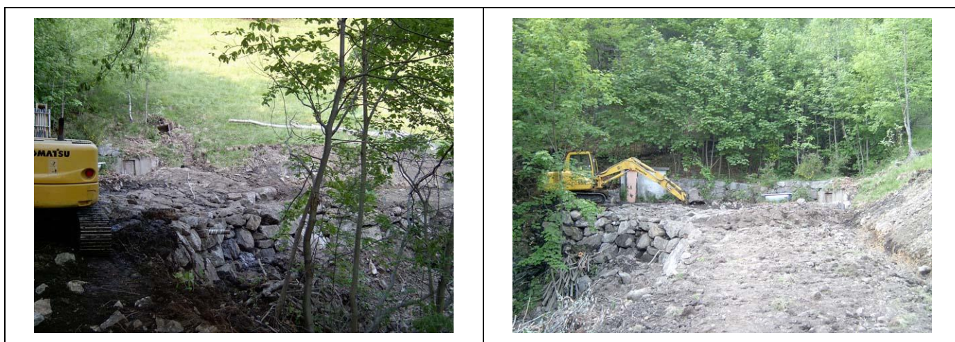
Particolare costruttivo di guado con andamento "a corda molle".
