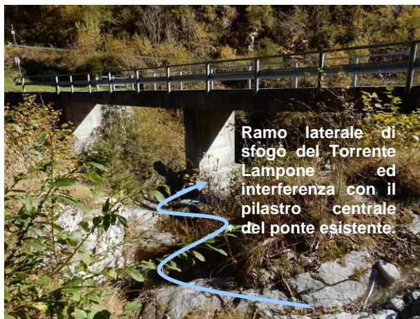
Fotografia 4 - Il ponte preesistente a servizio del sentiero di accesso alla destra idrografica della Val d'Egua (inizio Valle del Lampone) che sarà demolito e ricostruito con aumento della larghezza ma con adattamenti tecnico costruttivi meno impattanti.
