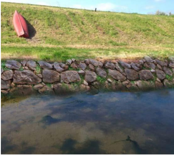
Scogliera con massi posati a secco e vani inerbiti.
